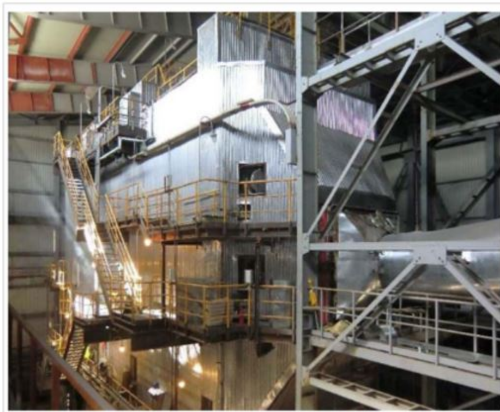
5.5-сурет. Мыс зауытындағы электр сүзгі
