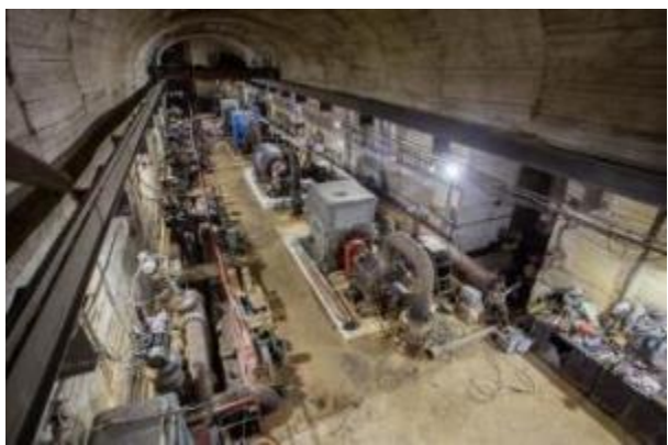
3.20-сурет. Шахталық су төккіштің сорғы камерасы
