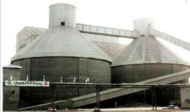
Рисунок 3.39. Круглые, без центральной опоры клинкерные склады
