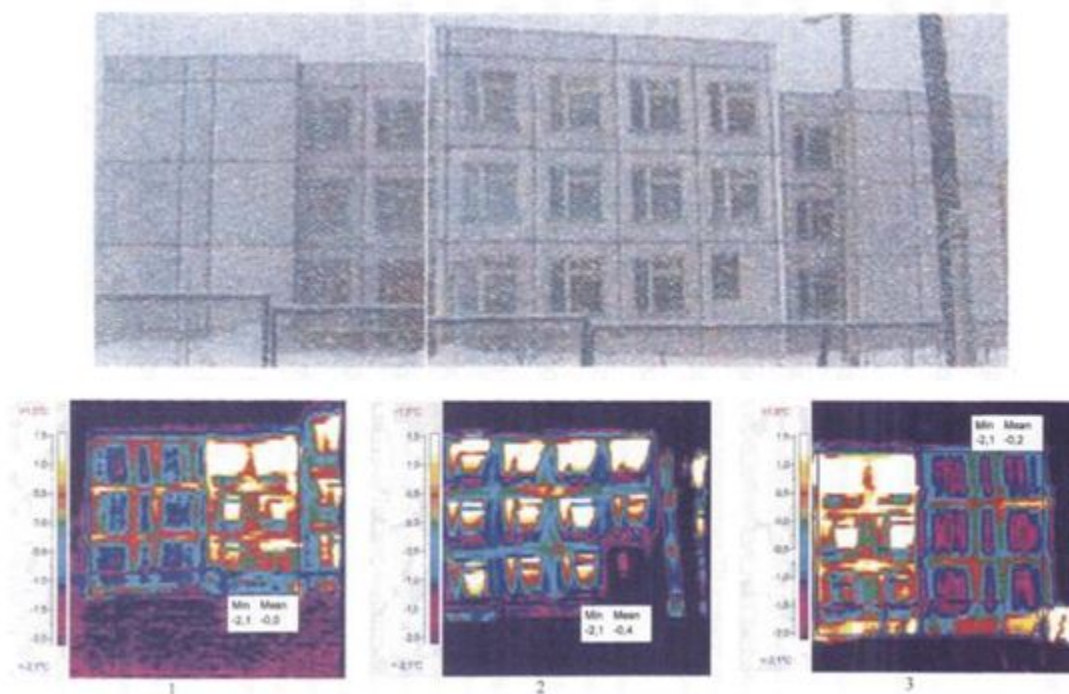
Рисунок 7. Термограмма ограждающих конструкций
